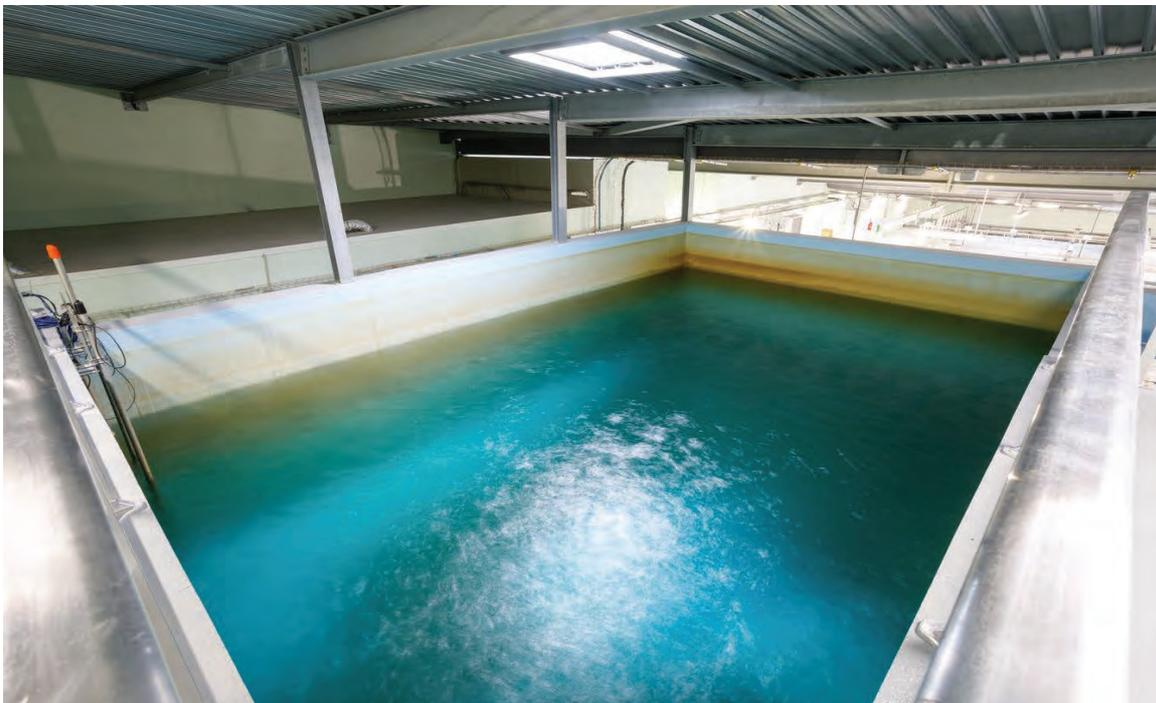
La limitation de la prolifération biologique dans l'eau des réservoirs est essentiellement axée sur la régulation de la quantité d'eau stockée dans le réservoir, de son temps de séjour et des conditions de stockage (luminosité, circulation, ...).
